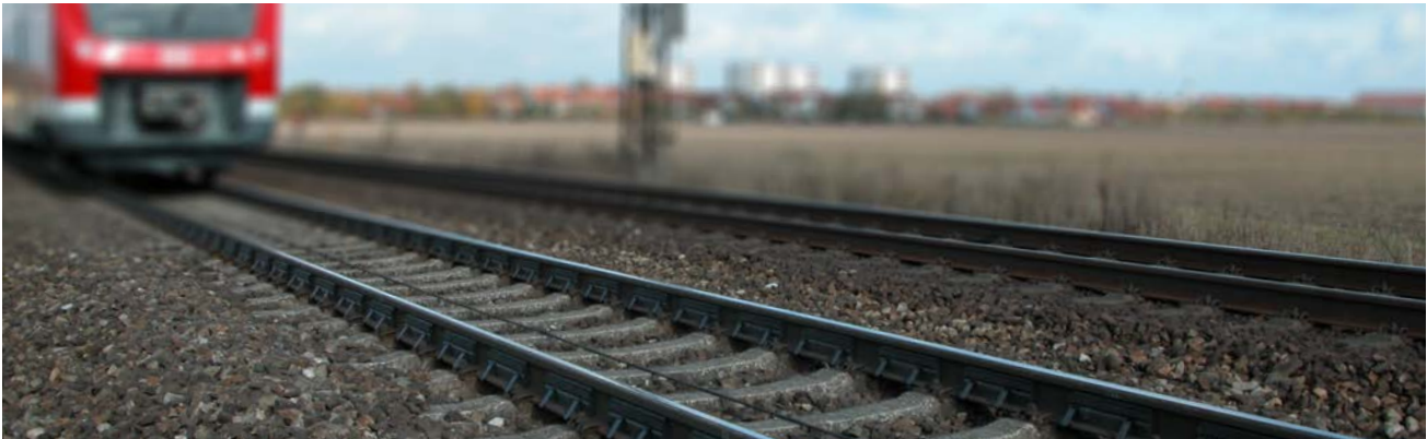
Schienenbefestigung mit Schienenstegdämpfung
